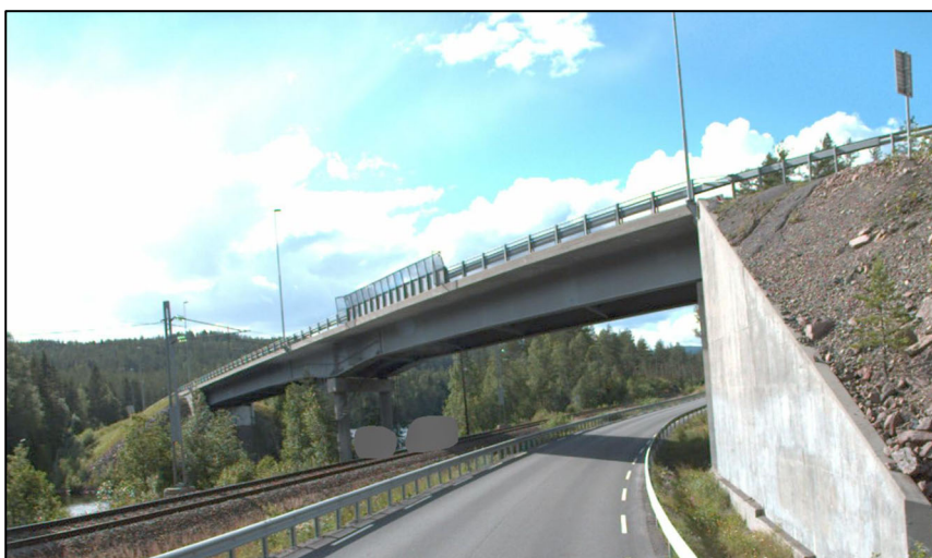
Bilete 1: Strekan bru, Rv.4 Viken, lengste spenn 96 meter, ÅDT 6700, kryssar òg jernbane og fylkesveg 2300. Foto: Vegbilder 2022.
